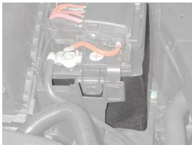
Habillage calorifuge de la batterie de la Golf millésime 2003
